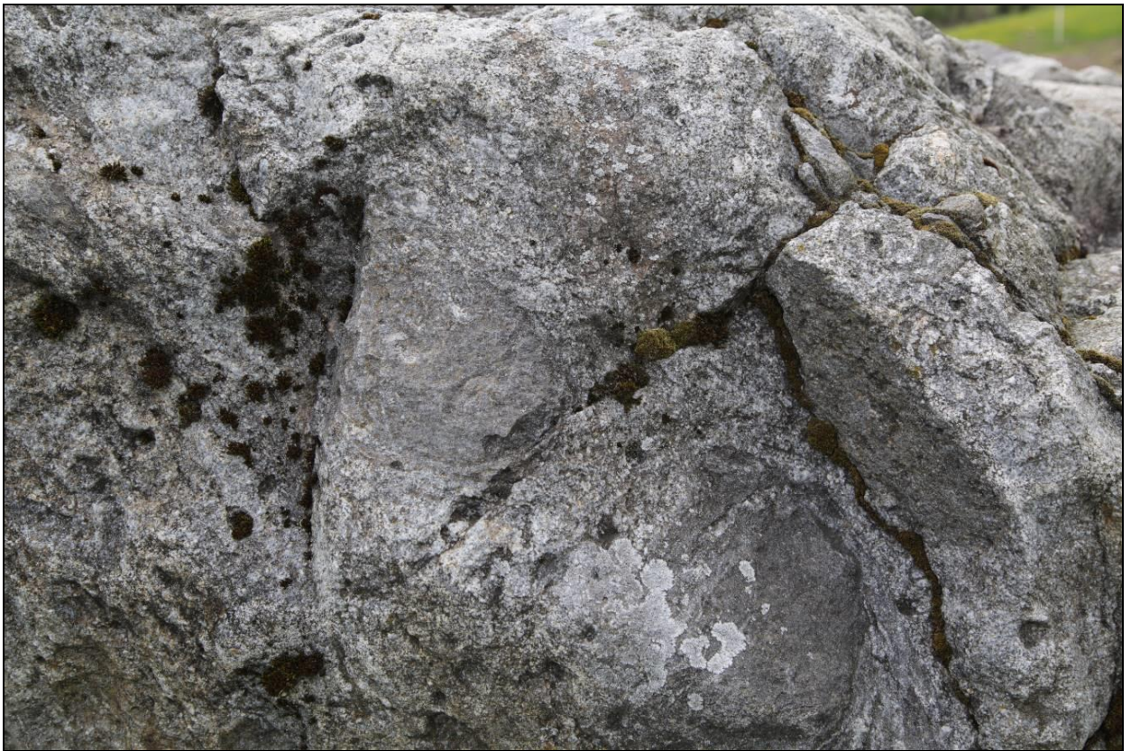
Riedulys apdūlėjęs ir pasėkoje atitrūkę uolienos gabalai paliko nelygų paviršių su įtrūkimų žymėmis
